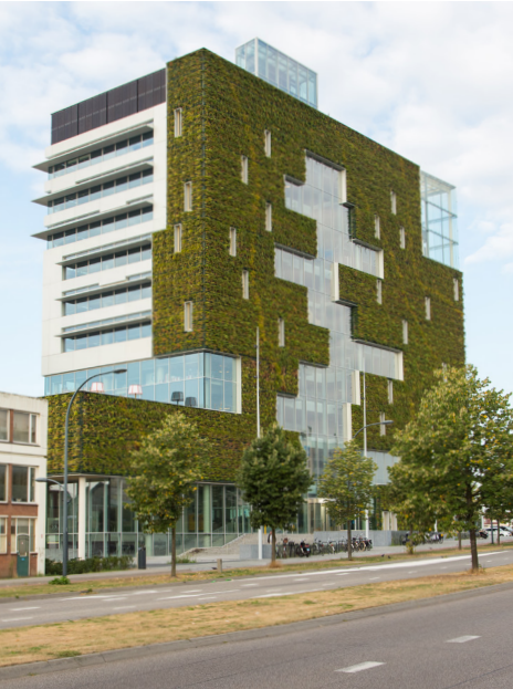
Norrsidan av stadshuset i staden Venlo består till stora delar av en grön vägg. På husets sydsida finns en damm med sandfilter som renar regnvatten och vatten från handfat etc. inne i byggnaden innan det används för att bevattna den gröna väggen och för att spola toaletterna.
